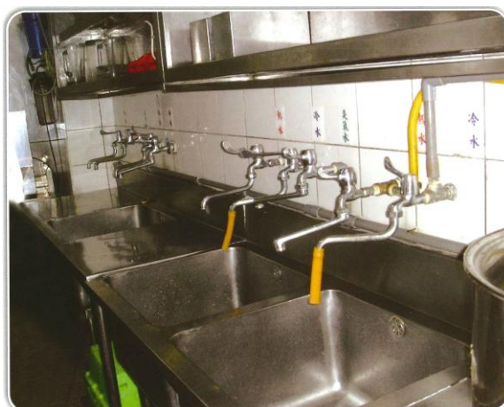
3-5 Thiết bị rửa phải có chức năng rửa, tráng và khử trùng hiệu quả (hình minh họa thiết bị rửa ba ngăn).
