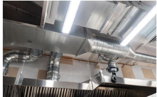
4-4 厨房には空気補給システムを設置すべきである。
