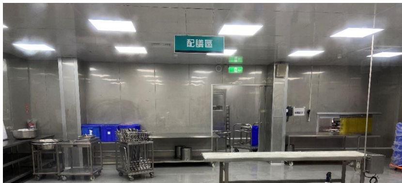
4-2 照明設備にはカバーによる保護が必要である。
