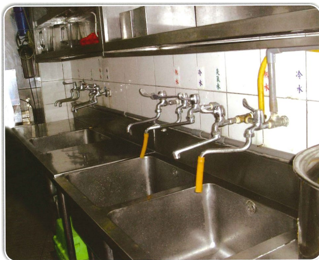
3-5 洗滌設備要具有洗滌、沖洗及有效殺菌之功能（圖為三槽式洗滌設備）
