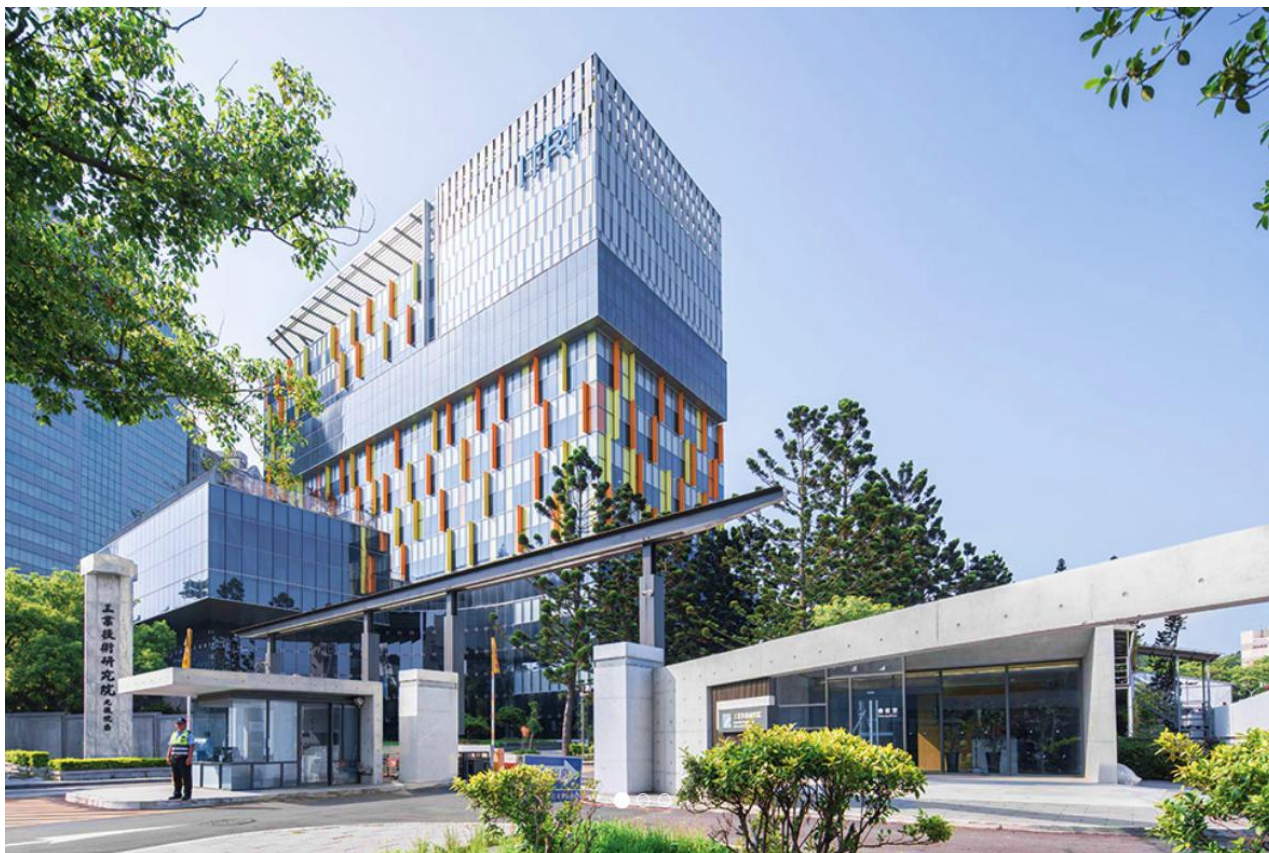
工研院光復院區 量測技術發展中心
