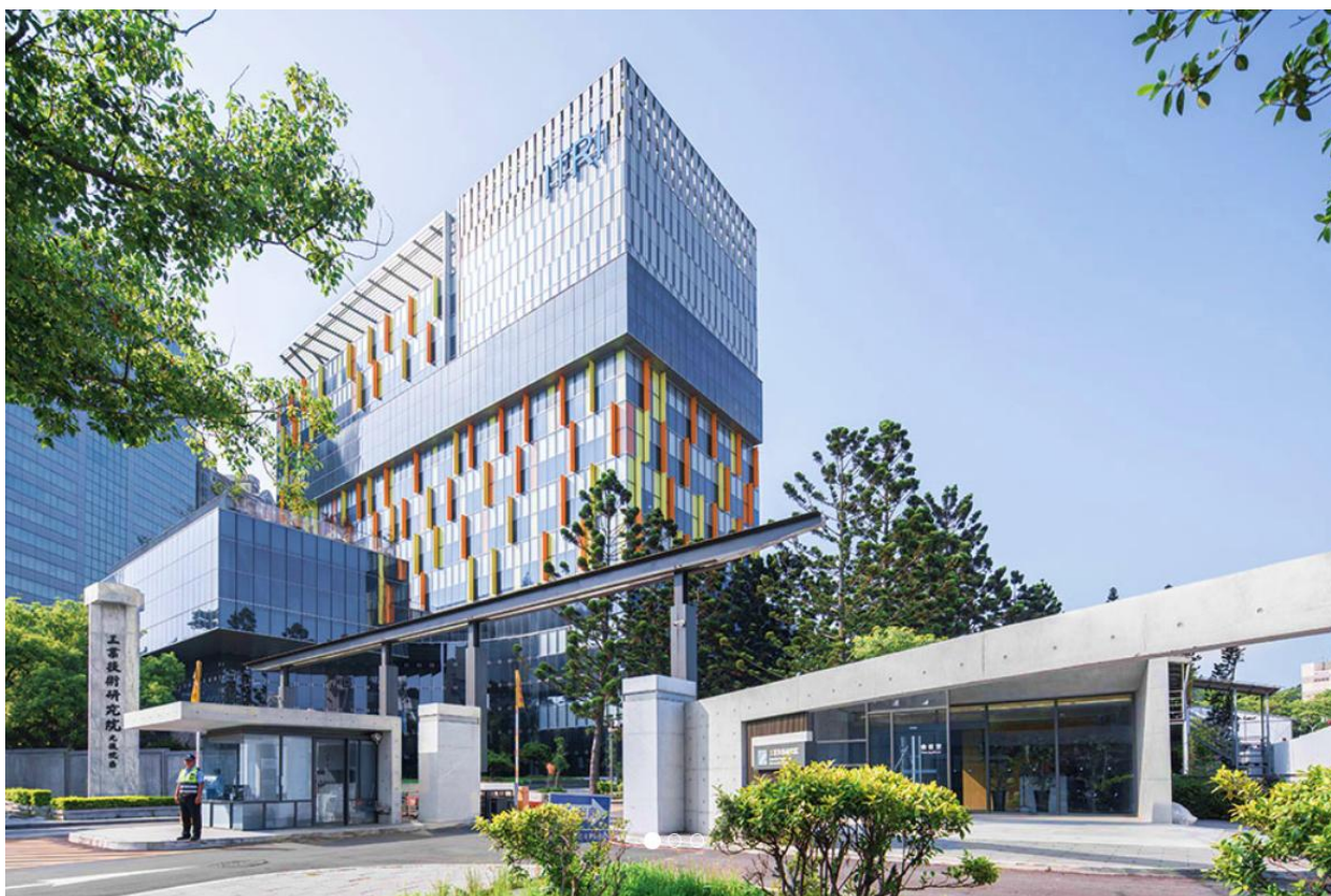
工研院光復院區 量測技術發展中心
