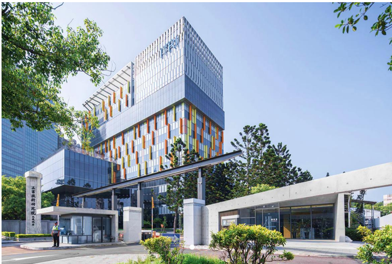
工研院光復院區 量測技術發展中心
