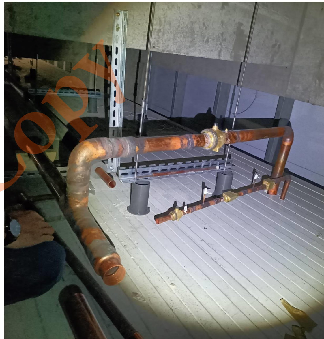
冷凍冷藏庫冷媒配管施工
