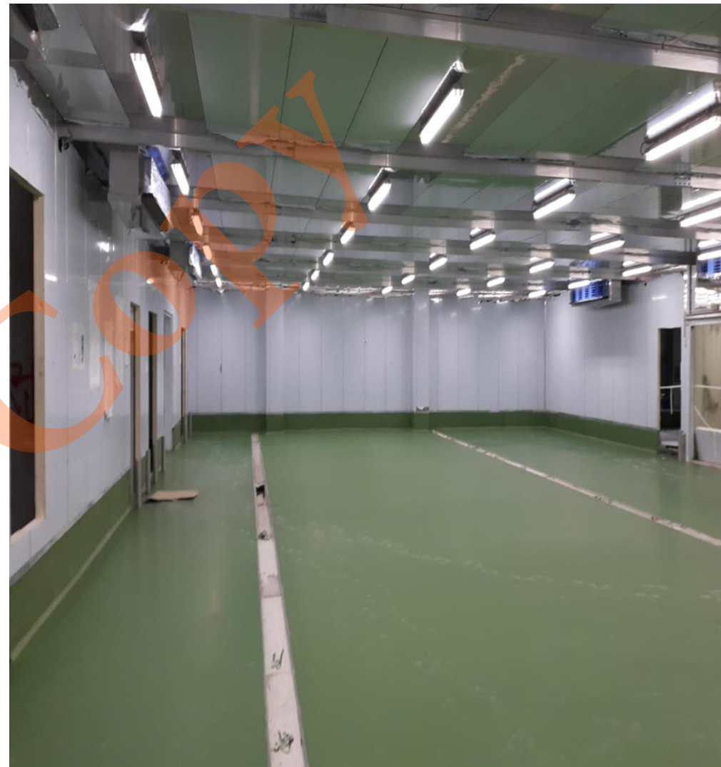
10~15℃ 低溫作業區排水溝施工
