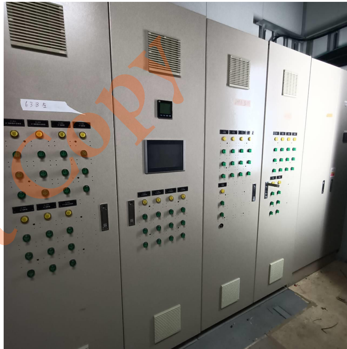
冷凍冷藏庫配電盤施工
