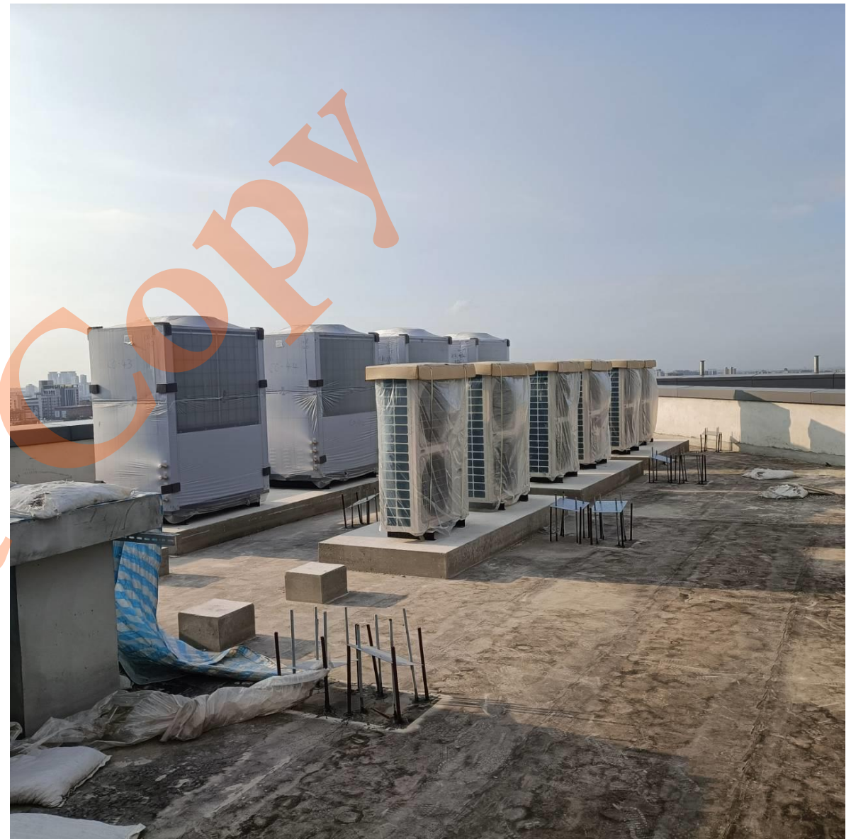
分散式冷媒直膨冷凍機組施工
