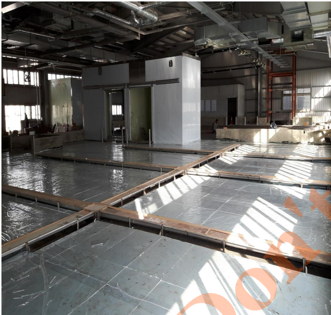
10~15℃ 低溫作業區排水溝施工
