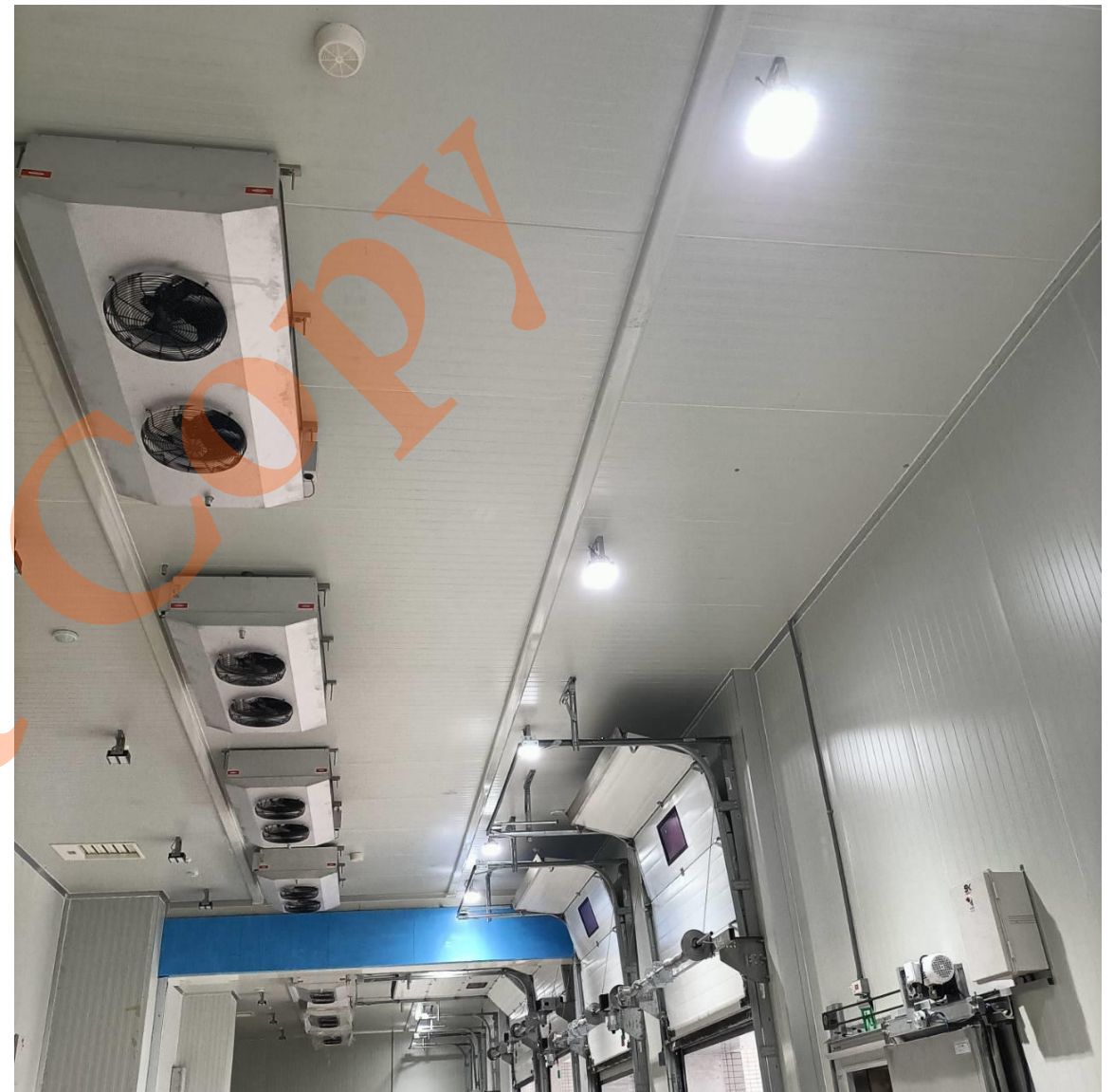
10~15℃ 貨物暫存區(下吹式冷風機)施工中
