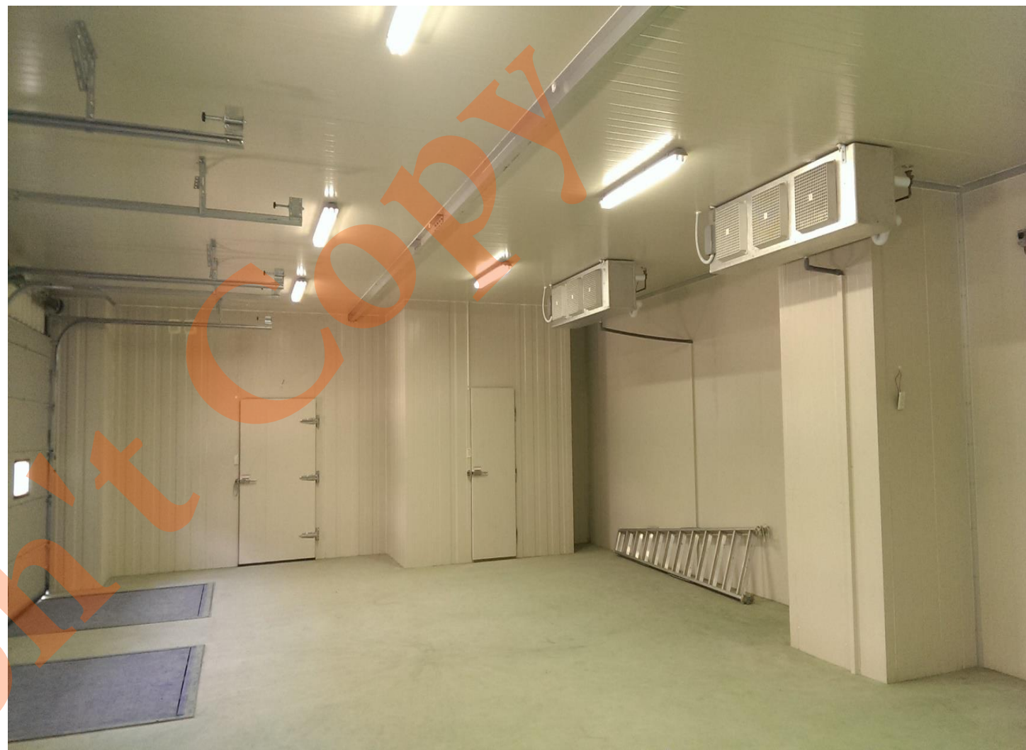
10~15℃ 貨物暫存區(側吹式冷風機)施工中
