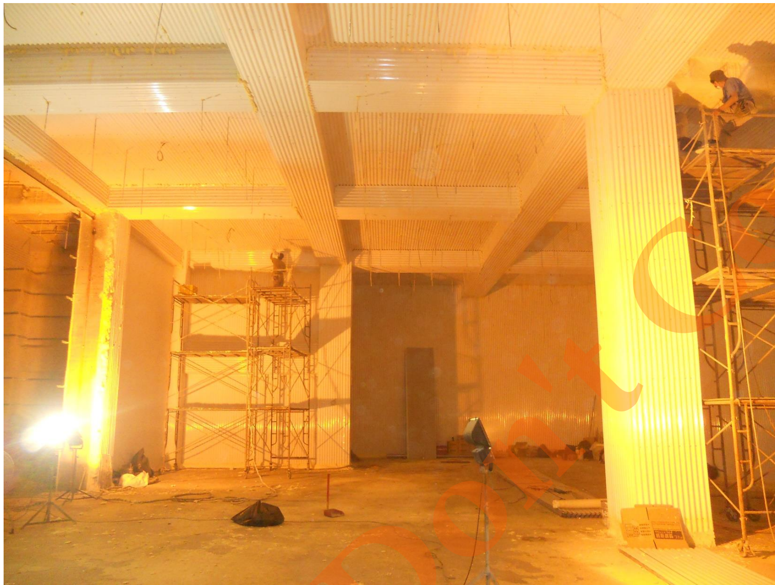
冷凍庫體施工-PU噴塗
