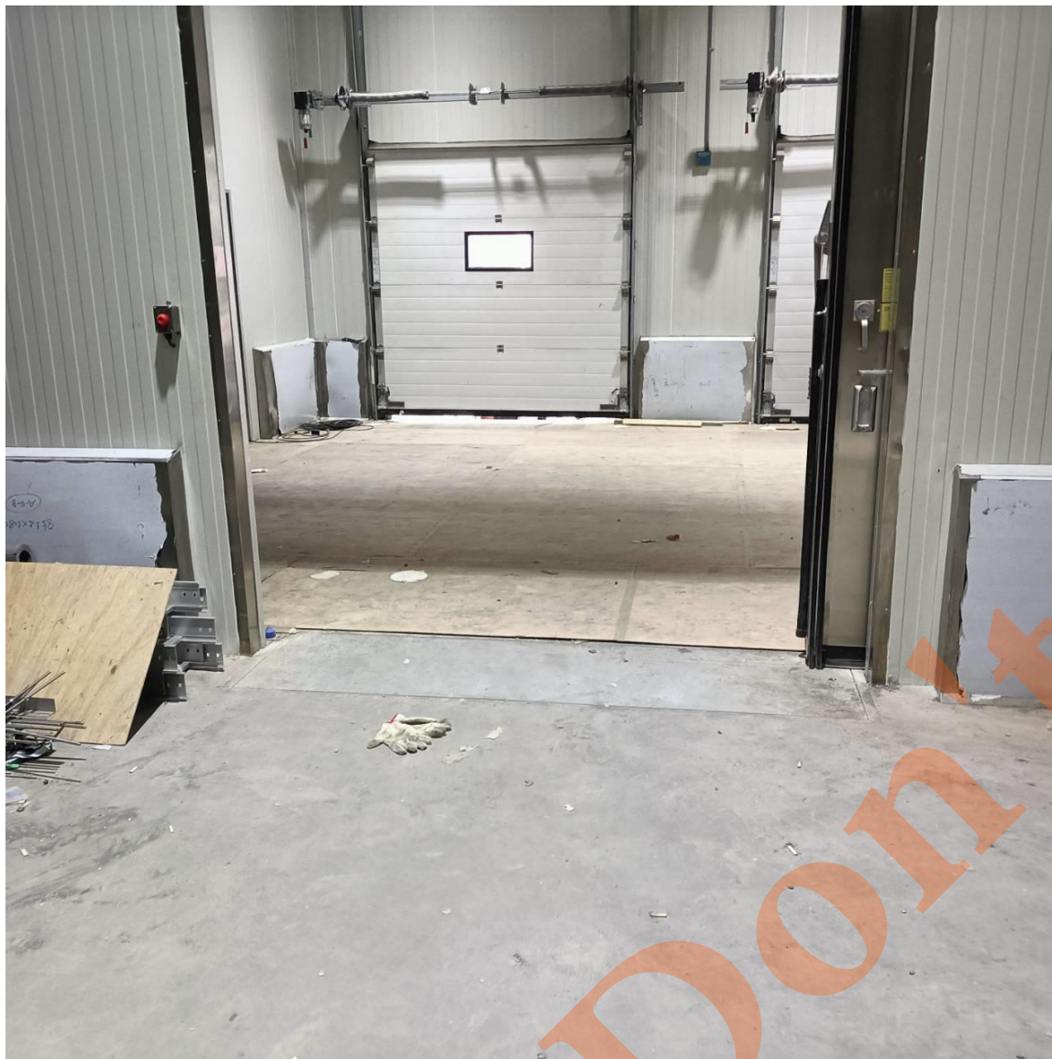
冷凍庫門口地板電熱施工
