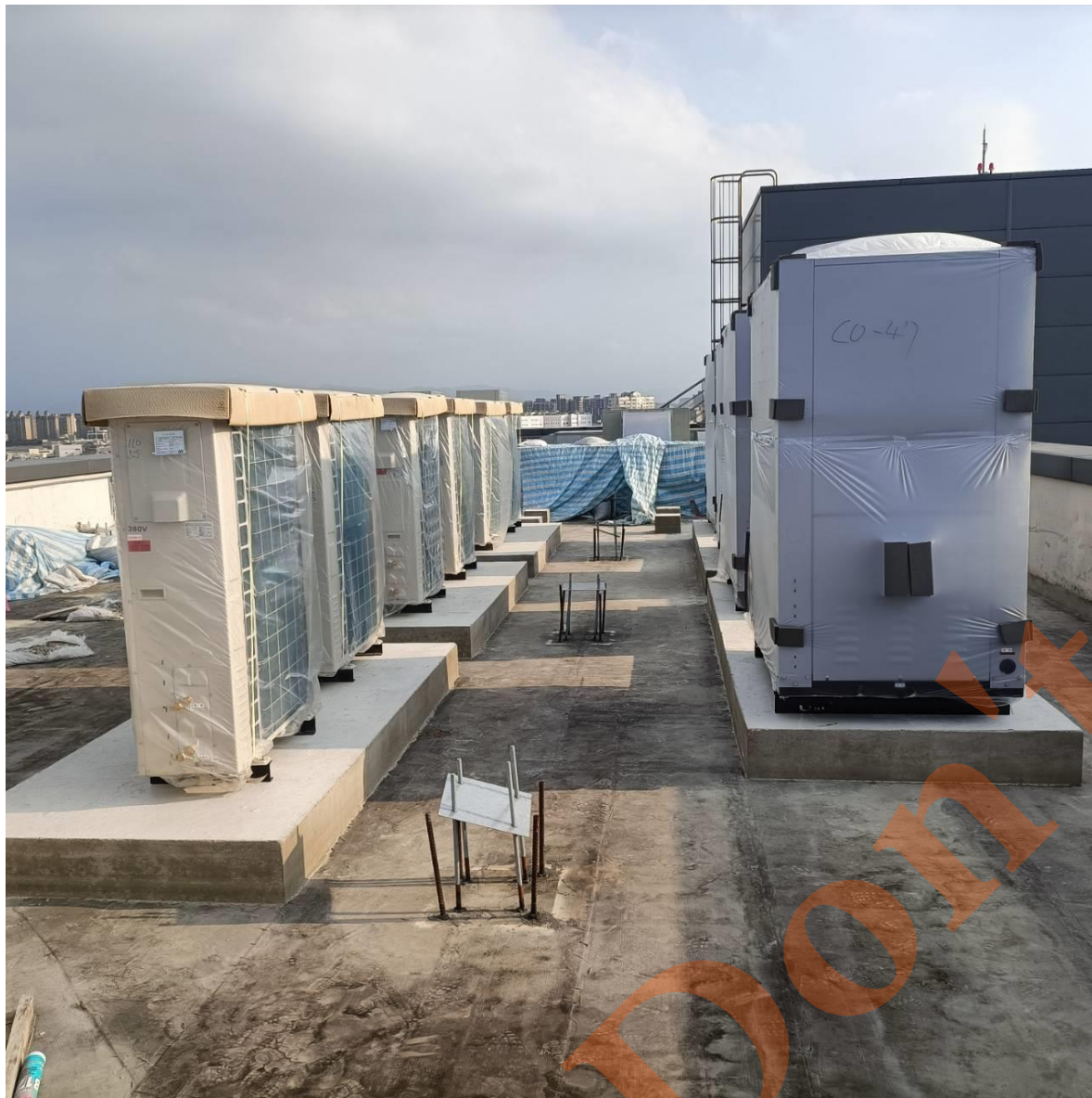
分散式冷媒直膨冷凍機組施工
