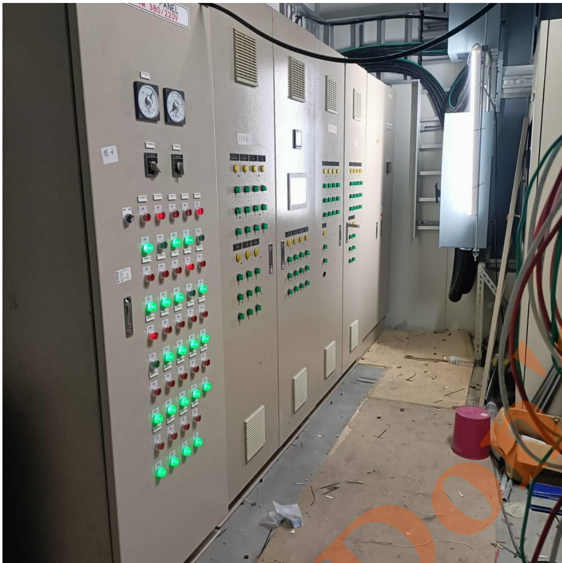
冷凍冷藏庫配電盤施工
