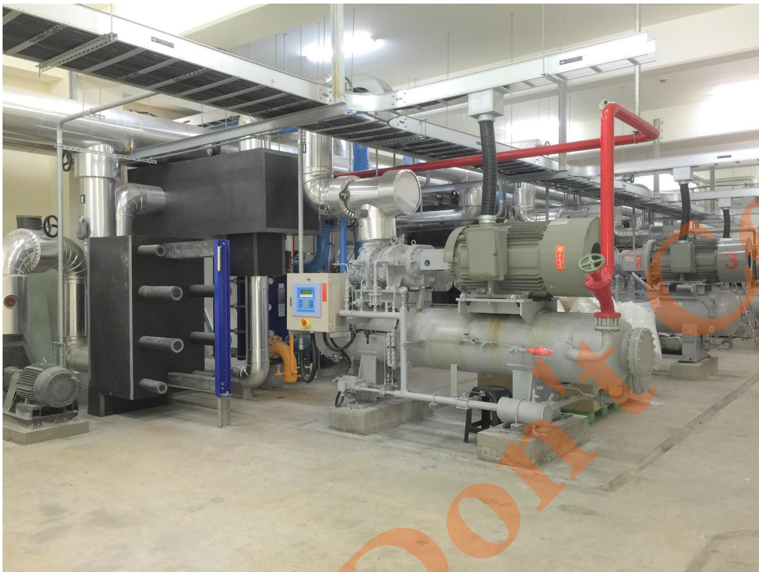
中央系統滷水冷凍機組/配電盤
