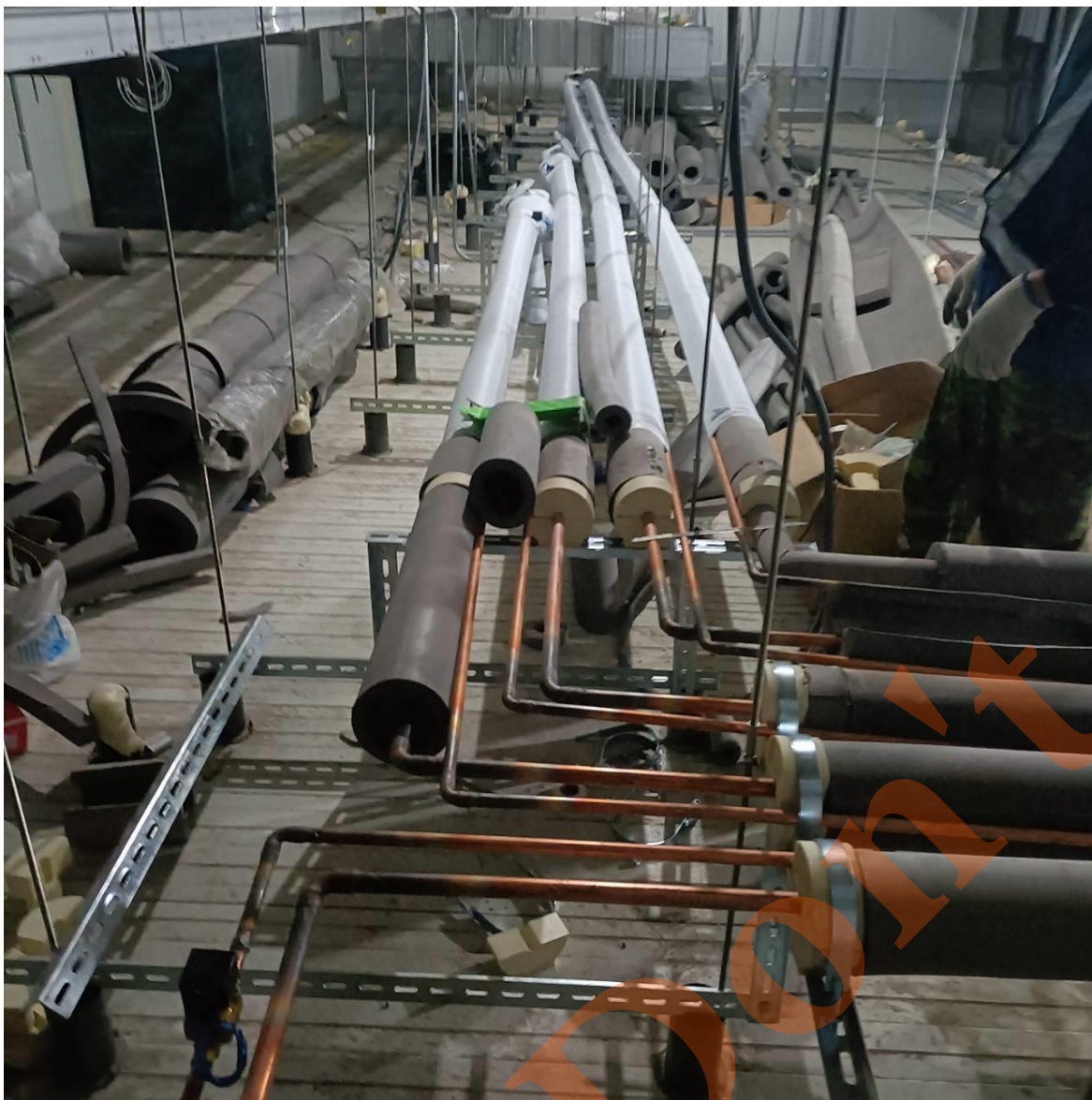
冷凍冷藏庫冷媒配管施工
