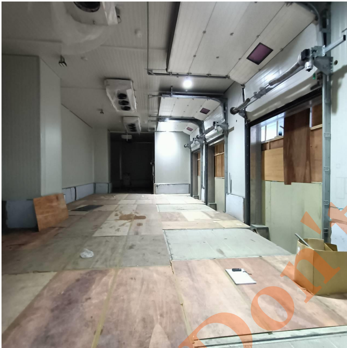
10~15℃ 貨物暫存區(下吹式冷風機)施工中
