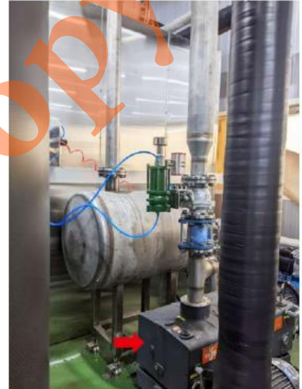
真空預冷系統用無油真空泵（箭頭所指）。（來源：李允中）
