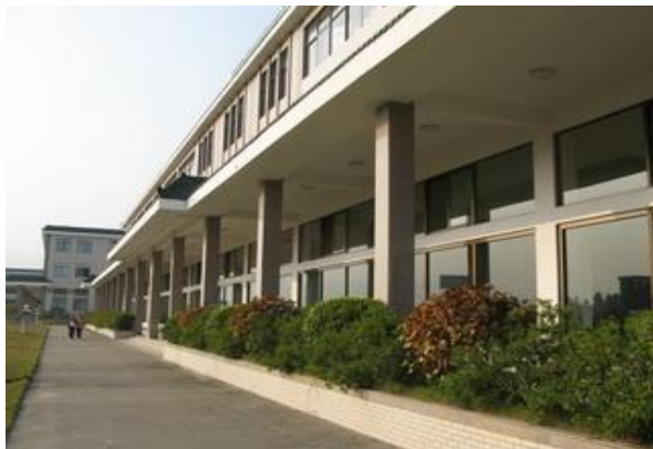
廠房與外隔離
