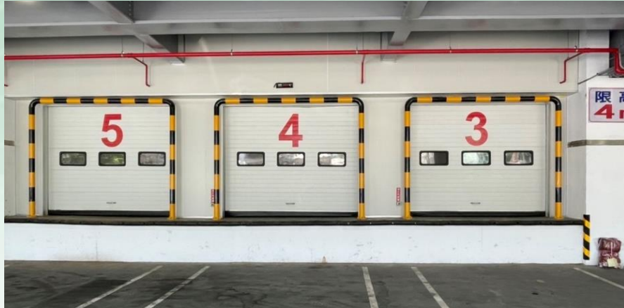
低溫冷鏈卸貨碼頭 氣密式門封，防止冷氣外洩
