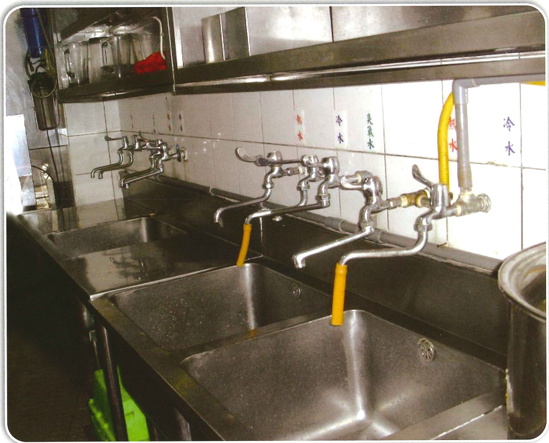
4-3 具有洗滌、沖洗及有效殺菌之三槽式洗滌設備
