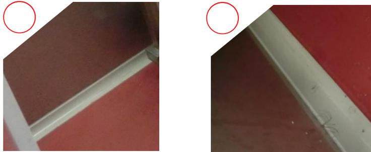
牆面與地面接縫處的 U 型施工
