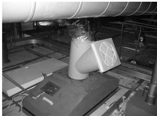
FFU系統，較難施作PAO洩漏測試，並且邊框容易出現洩漏；更換HEPA的難度較高
